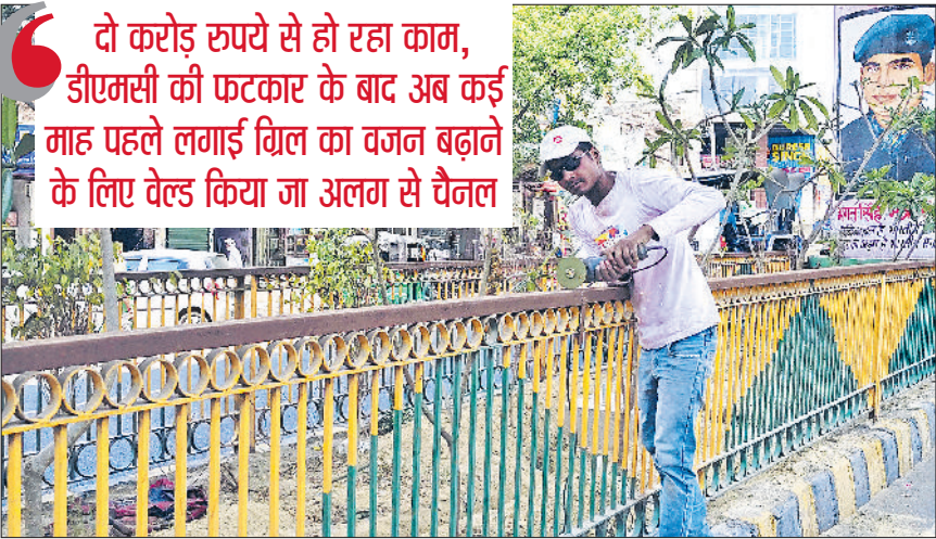
बहादुरगढ़। डिवाइडर पर लगी ग्रिल के ऊपर चैनल लगाते कर्मचारी।
